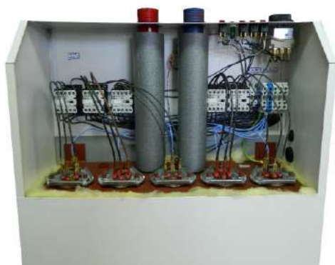
EI-Cm Basic 30kW - 36kW modell (belső)
